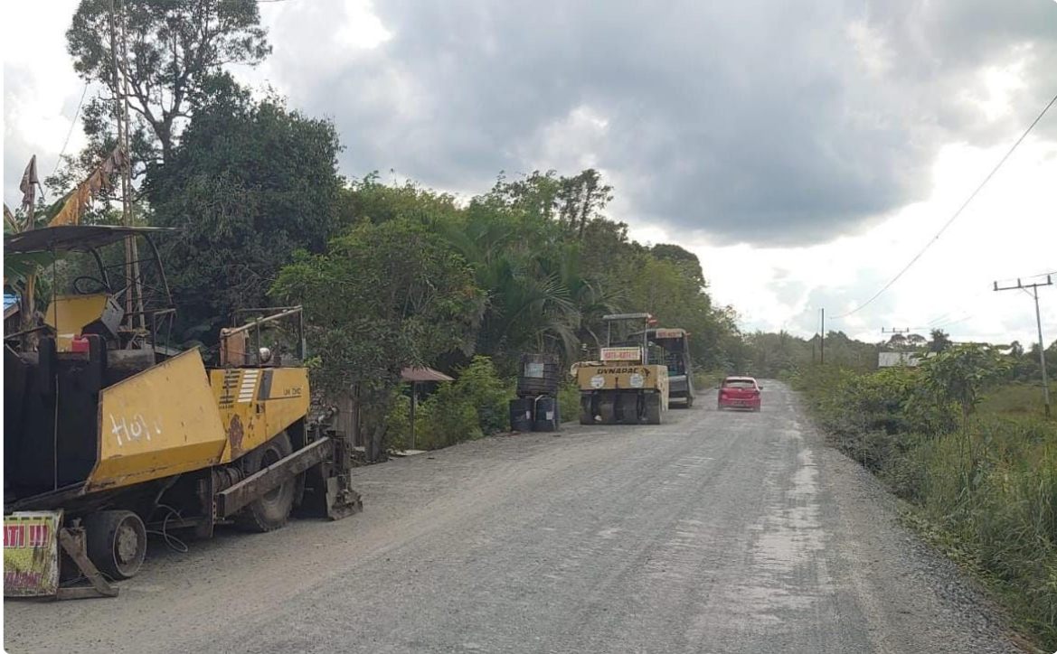
Gambar: Kondisi agregat di desa lembeng siap dilaksanakan pengaspalan
