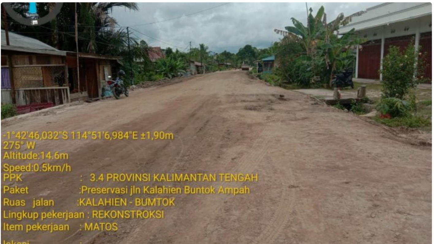
Gambar: Kondisi Terbaru Ruas Jalan Kalahien - Asam, Bontok.
